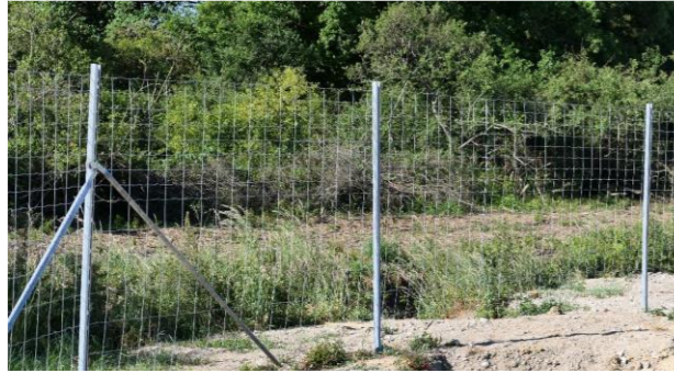
Figure 9 - Clôture à mailles progressives à Argent-sur-Sauldre (18)
