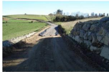
Mise en place du gravier
