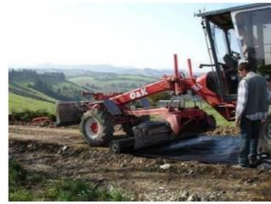
Pose du géotextile
