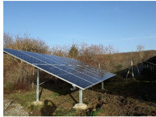
Figure 13 : Exemple de pieux forés bétonnés et battus
