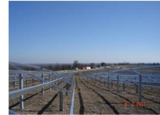
Figure 14 : Montage des structures porteuses
