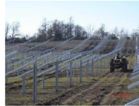
Figure 14 : Montage des structures porteuses
